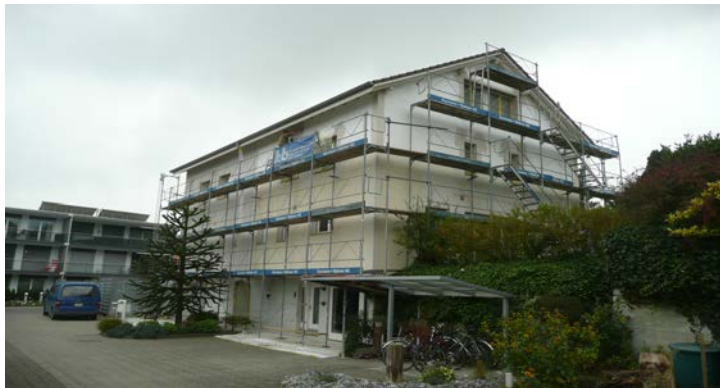
Umbau Fassade Rosenweg 1 + 3 Sursee
