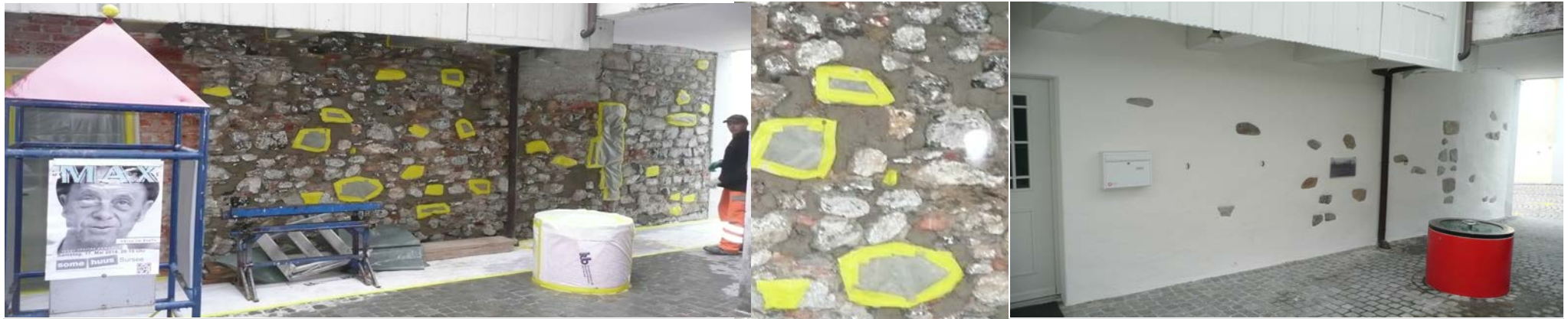
Mauerwerkssanierung - Fassade Somehus - Sursee
