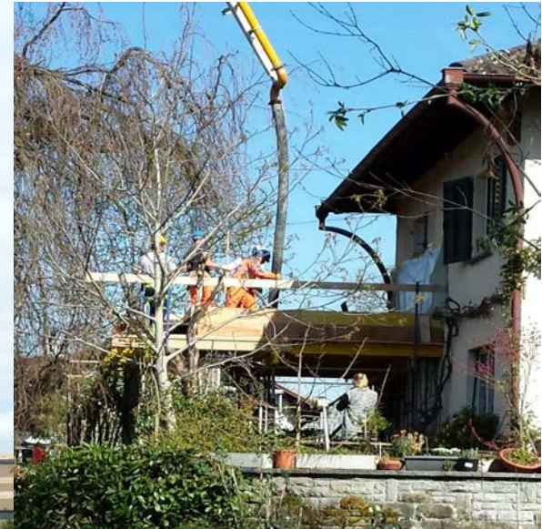
Umbau DEFH Stocker - Mariazellweg - Sursee
